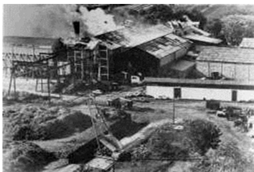
Vestiges de l'usine du Lareinty
